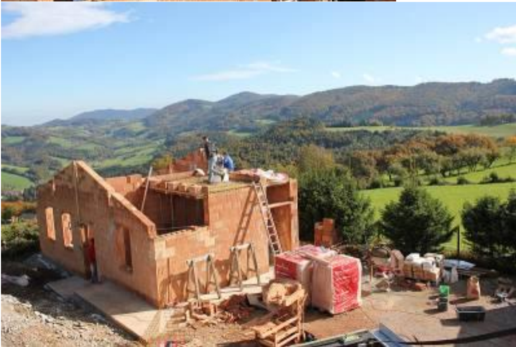
Der Baufortschritt zeigt sich am besten von oben, aufgenommen von der großen Kuppel.
