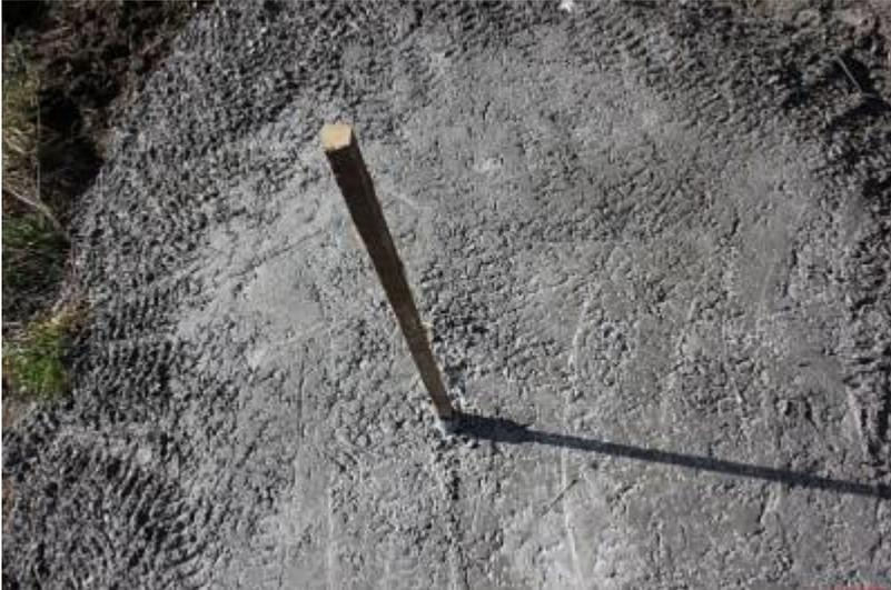
Nachdem die Schalung der Säule beim Füllen dem Druck des Betons nicht stand hielt, wurde dieser gleich als Grundfundament für unsere geplante Radioantenne e-Callisto aufgetragen
